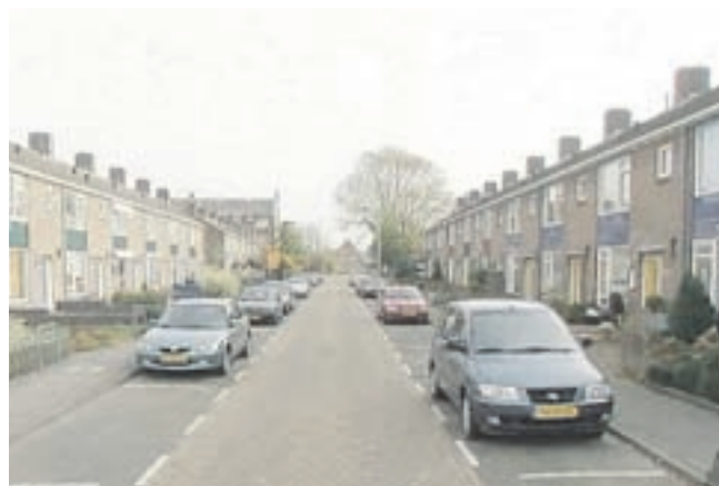
Het huidige straatbeeld van de IJsselstraat
